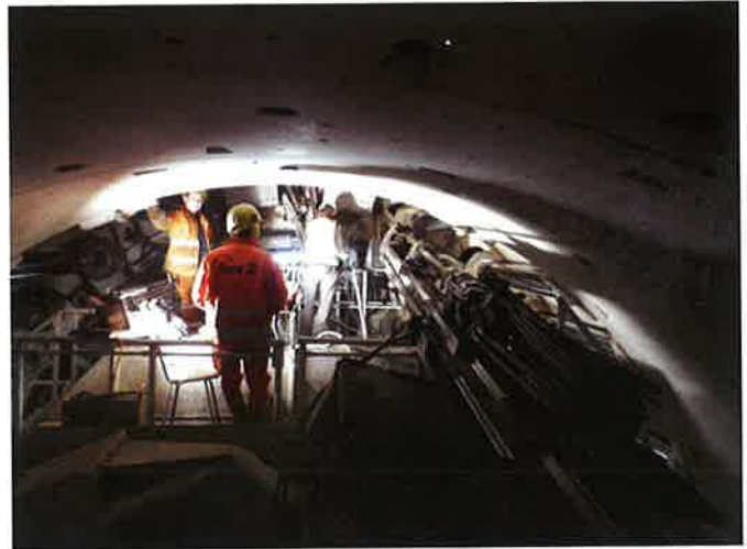
Fig. 1. Probe drill assembling Bild 1. Bohreinrichtung für Erkundungsbohrung
